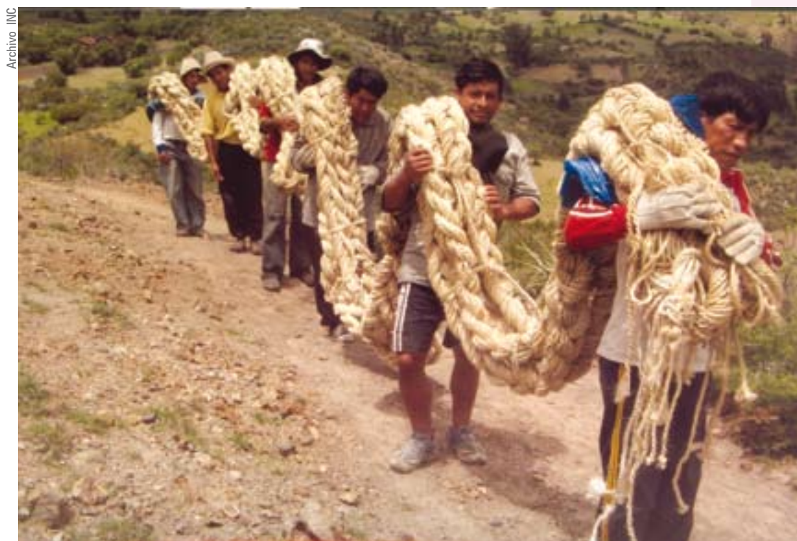
Trabajos para el tendido del puente colgante Pukayaco, Ancash
