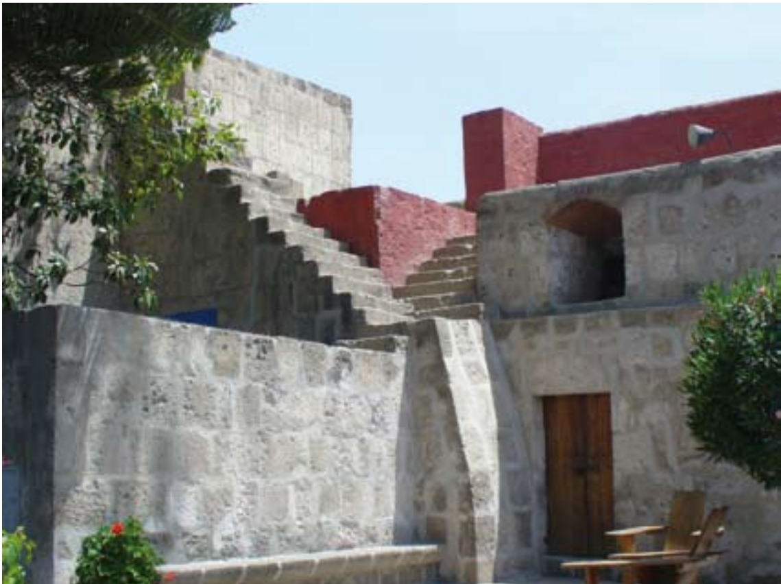
Convento de Santa Catalina, Arequipa
