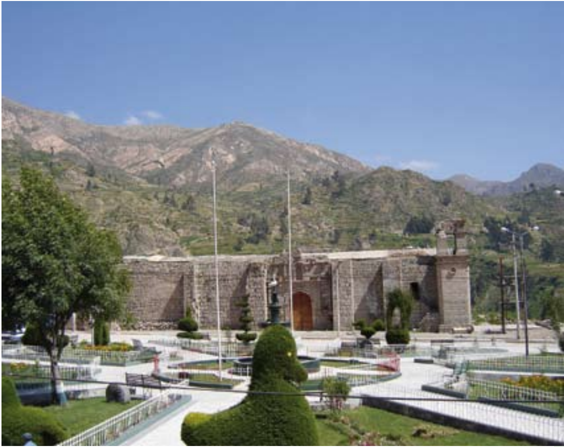
Iglesia de Carumas, Moquegua
